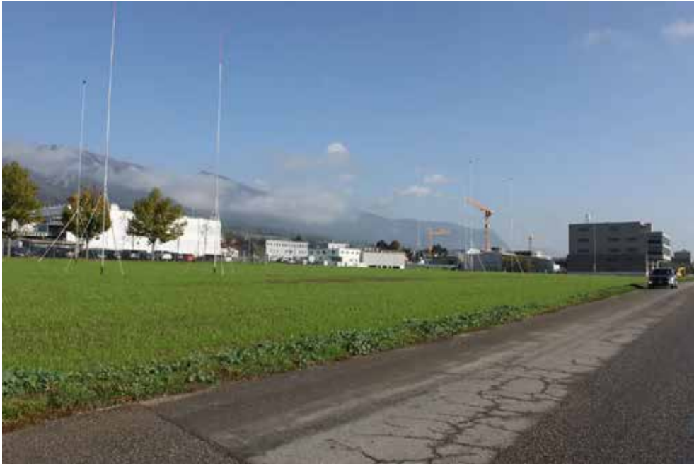
Bauplatz an der Lebernstrasse in Grenchen.
